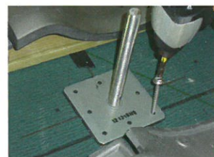
固定金具の取り付け(アンカー方式)
